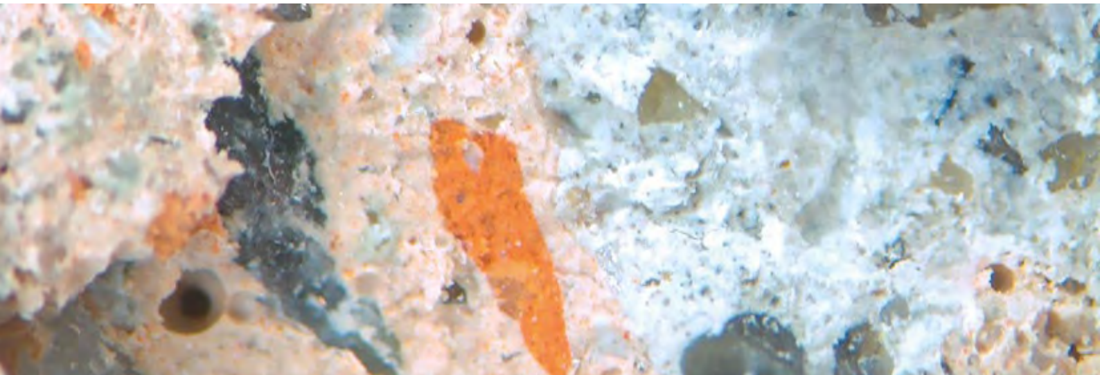
Übergang zwischen Altbeton (grau) und neuem Beton mit Ziegelmehl (rosa)
