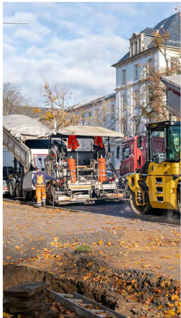
Foto: Teichmann Bau GmbH
