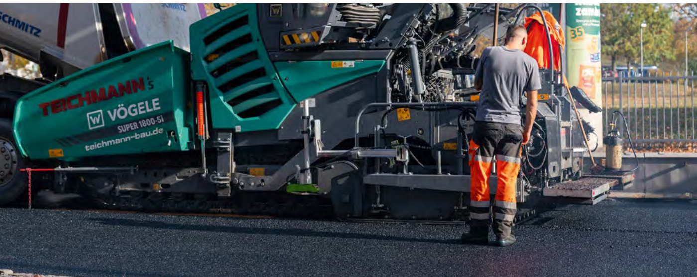
Foto: Teichmann Bau GmbH
